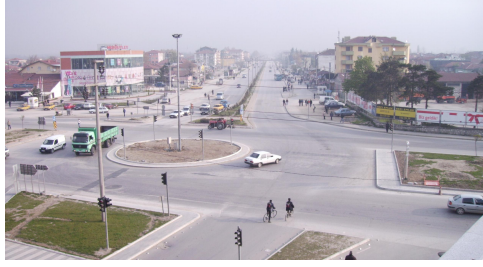
Şekil 4: Çoban kavşağının mevcut durumu.
