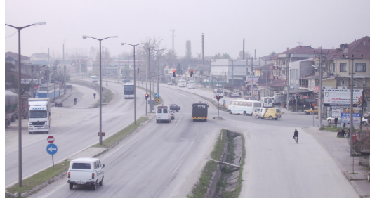
Şekil 5: Kervan kavşağının mevcut durumu.
