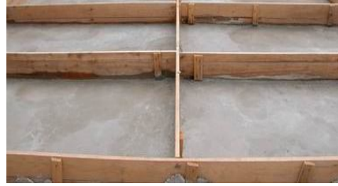
Şekil 1. Betonun kalıba yerleştirilmesi
