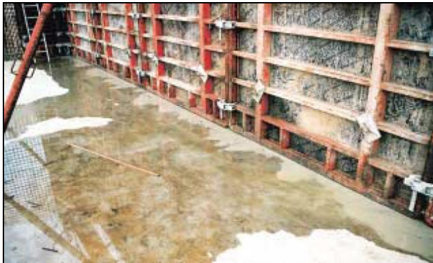
Şekil 11. Geçirgen kalıplardan drene edilen karışım suyu.
