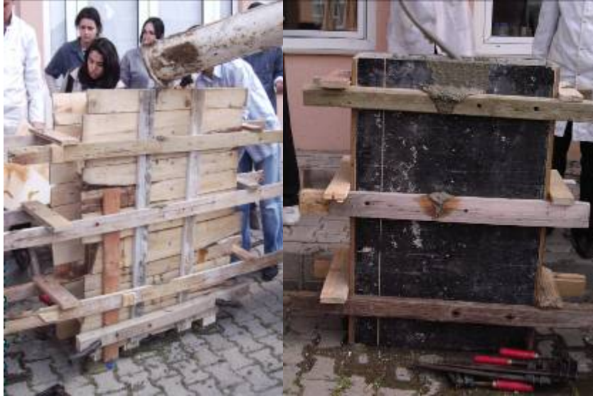
Şekil 2. Hazırlanan kalıpların içerisine beton dökümü (Concrete casting at prepared formworks)
