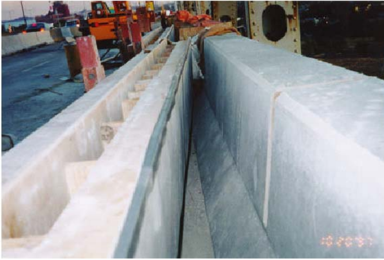
Resim 2.7 Trafik bariyerlerinin astarlı kalıplar kullanılarak dökülmesi
