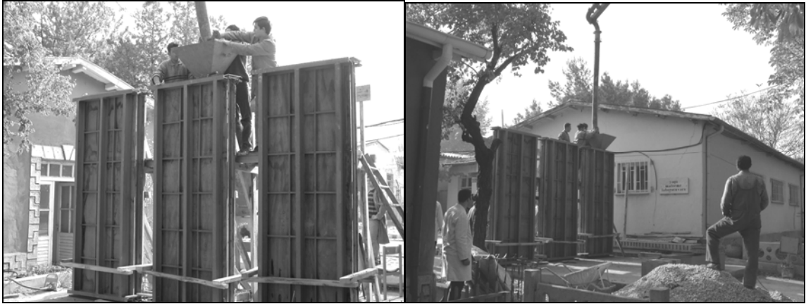
Resim 4.2 Transmikser ve pompa yardımı ile betonun kalıplara dökülmesi
