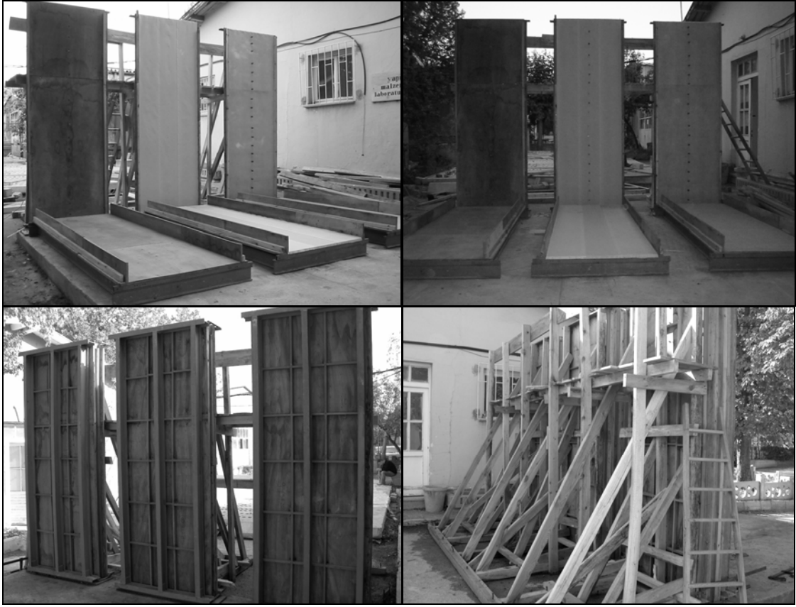
Resim 4.1 Kalıp örneklerinin yapım süreci ve sabitleme görüntüleri
