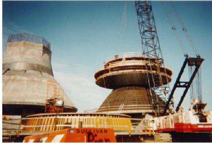
Resim 2.5 Konfederasyon köprüsü ayağının temeli üzerindeki tekstil astarlı ahşap kalıp
