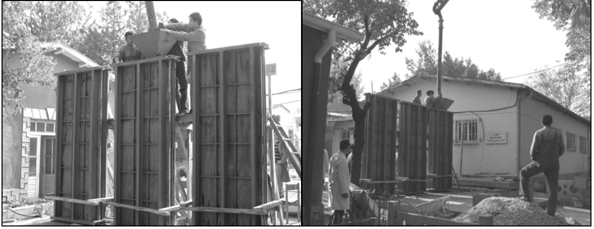
Şekil 6-4 Transmikser ve pompa yardımı ile betonun kalıplara dökülmesi
