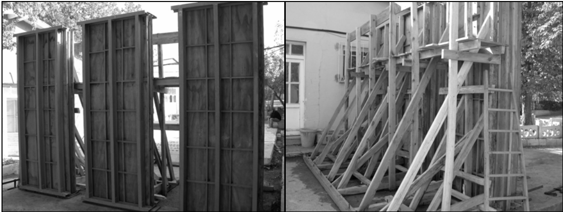
Şekil 6-2 Perde duvar kalıpları
