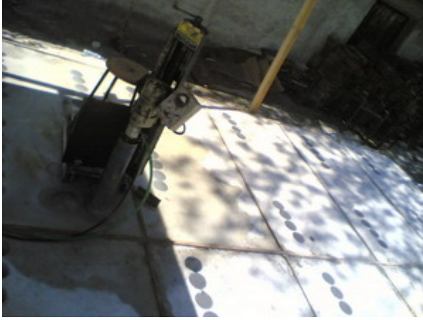
Resim 3.3. 7 günlük alınmış karot numunelerin görünüşü
