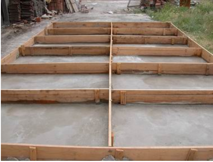
Resim 3.1. Beton dökülmeden önceki kalıp yerleşimi
