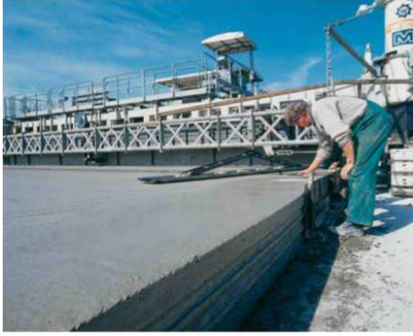
Resim 2.7. Beton yol alışmasına ait bir rnek
