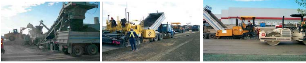
Resim 2.10. Silindirle sıkıştırılabilen beton yollara ait fotoğraflar
