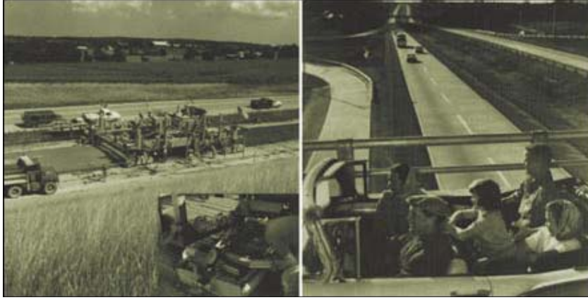
Resim 2.3. Avrupa ülkelerindeki beton yollara ait fotoğraf
