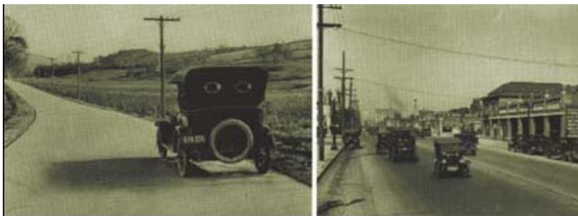
Resim 2.2. 1920 yılındaki beton yoldan bir görünüm
