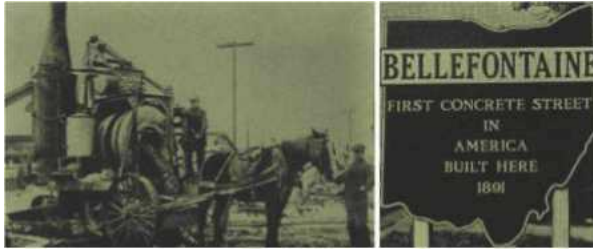
Resim 2.1. ilk beton yol
